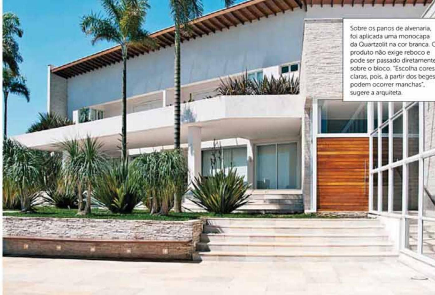
Sobre os panos de alvenaria, foi aplicada uma monocapa da Quartzolit na cor branca. O produto não exige reboco e pode ser passado diretamente sobre o bloco. “Escolha cores claras, pois, à partir dos bejes, podem ocorrer manchas”, sugere a arquiteta.
